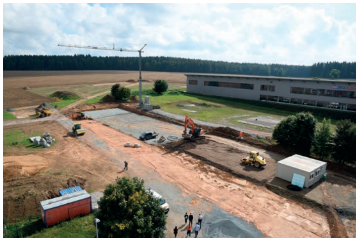
Blick auf die Baustelle, Foto: LRA
