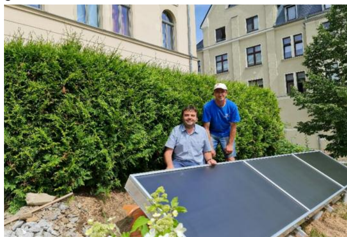
TWV-Geschäftsführer Alexander Spitzner (l.) und Monteur Steffen Fröhlich an den neuen Solarmodulen. Foto: TWV
