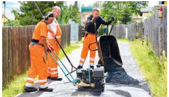
Die Mitarbeiter des Kommunalstützpunktes Karl-Heinz Heyer, Andreas Strube und Heiner Lisch (v.l.) bringen die Bitumenmasse auf der Straße Am Wartberg in Schreiersgrün aus. Foto: pko
