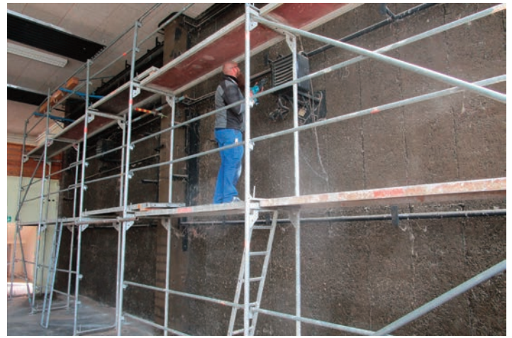
Eric Weiß beim Rückbau alter Installationen
