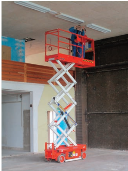
Mitarbeiter der Fa. Elektro-Gruschwitz bei der Installation neuer LED-Leuchten
