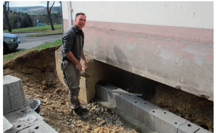
Jörg Kühn von der Fa. ZOBAU bei der Untermauerung der giebelseitigen Wandplatten
