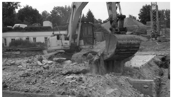
Die alte Bodenplatte des Nichtschwimmerbeckens musste abgebrochen und neu gegossen werden.
